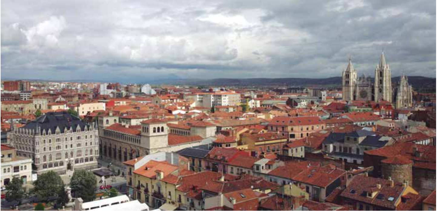
La ciudad de León desarrolla el proyecto de construcción de una red térmica para abastecimiento residencial.
